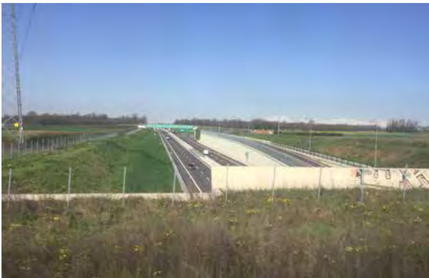
A fianco, Autostrada Pedemontana Lombarda
